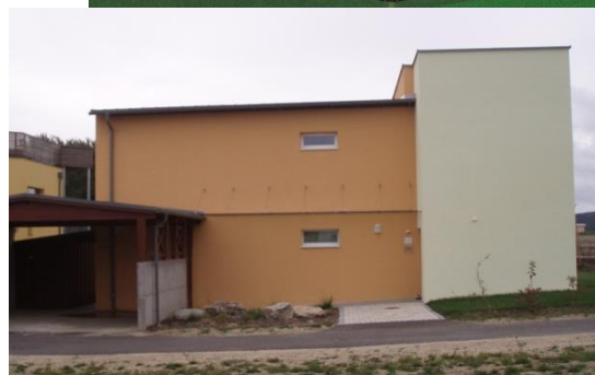
Nordseite eines Passivhauses kleine und wenige Glasflächen
