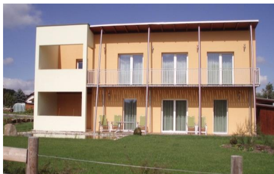
Südseite eines Passivhauses große Glasflächen
