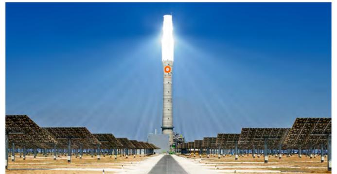
ABBILDUNG 267: Turmkraftwerk Gemasolar in Sevilla, Spanien, mit 19,9 MW Leistung, Turmhöhe 14m - BILD: Torresol Energy
