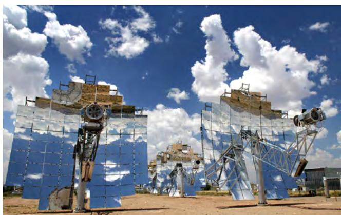
ABBILDUNG 269: Dish-Stirling-Anlage mit 25 kW
