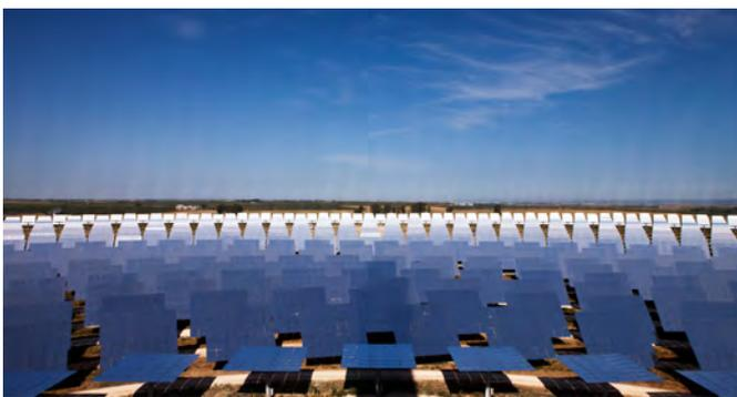
ABBILDUNG 266: Turmkraftwerk Gemasolar in Sevilla, Spanien, mit 2.650 Heliostaten auf 195 Hektar - BILD: Torresol Energy
