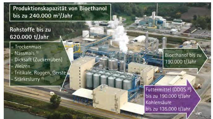
ABBILDUNG 164: Bioethanol-Produktionsanlage Pischelsdorf, 1) maximal zwei Monate während der Erntezeit, 2) Nebenprodukt aus der Stärkeerzeugung bei der neben Stärke auch Klee und Gluten erzeugt werden, 3) Distillers Dried Grains with Solubles (Trockenschlempe, feste Nebenprodukte der Destillation)
