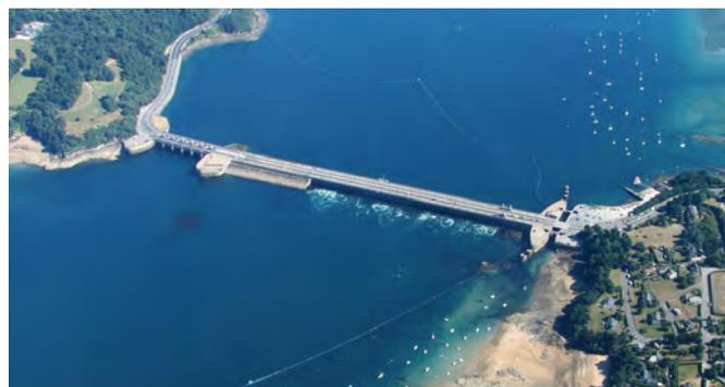
ABBILDUNG 219: Gezeitenkraftwerk La Rance, Frankreich, 240 MW in Staudammbauweise - BILD: Benoit Marember
