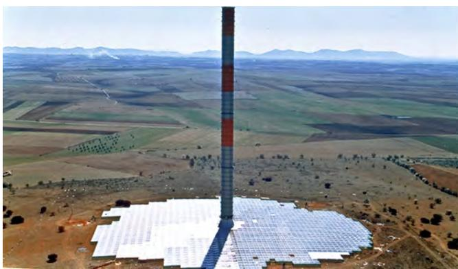
ABBILDUNG 279: Prototyp Manzanares, 122 m hoch mit 50 kW
