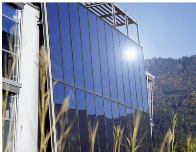
ABBILDUNG 245: Aufbau eines Flachkollektors, (rechts) Fassadenflachkollektor - BILD: GreenOnetec
