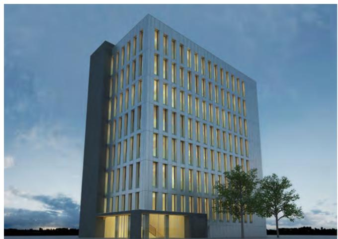
ABBILDUNG 250:  $\text{CO}_2$ -neutrales Holzhybridhaus: LifeCycleTower in Dornbirn, mit über  $10.000 \text{ m}^2$  eines der größten Holzhäuser in Europa - BILD: Hermann Kaufmann
