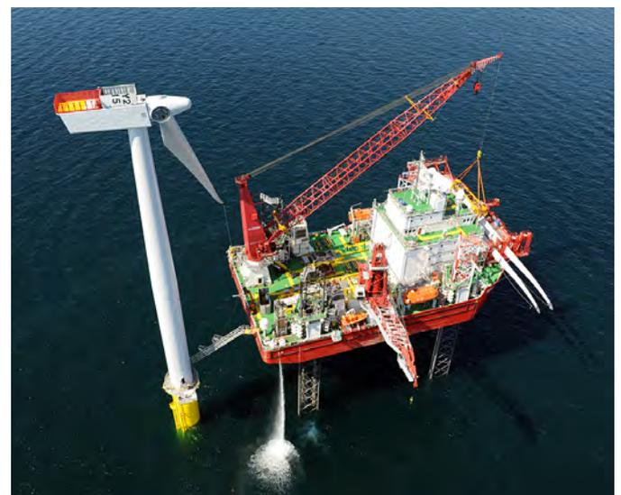
ABBILDUNG 229: Errichtung von Windkraftanlagen mit 6 MW Leistung und 135m Höhe - BILD: Courtesy of Dong Energy
