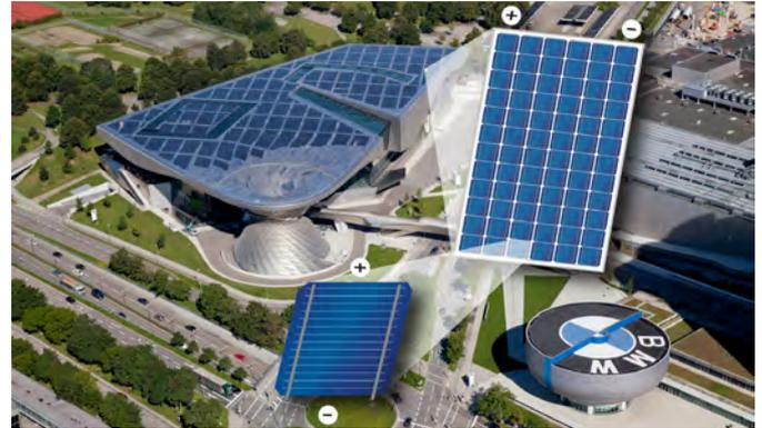
ABBILDUNG 257: PV-Anlage BMW in München. Solarstrings bestehen aus Solarmodulen die sich aus einzelnen Solarzellen zusammensetzen - BILD: Solarwatt
