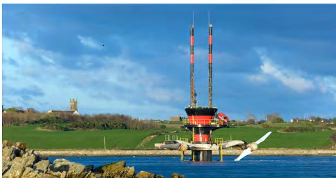
ABBILDUNG 218: Seagen-Strömungsanlage in Strangford, Nordirland, 1,2 MW
