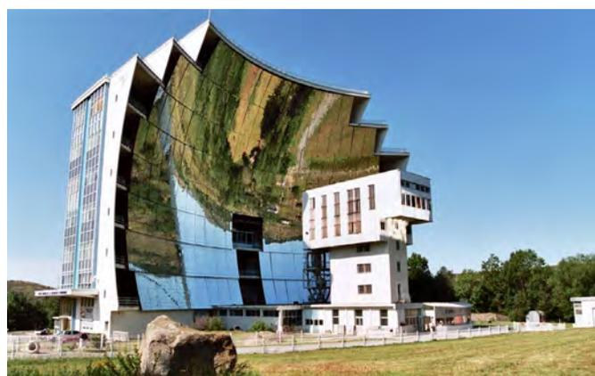
ABBILDUNG 271: Solarschmelzofen in Odeillo/Südfrankreich mit 1 MW thermischer Leistung – BILD: Four solaire odeillo
