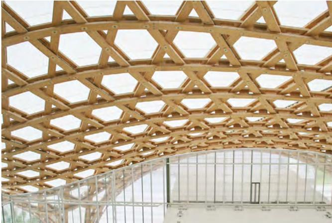
ABBILDUNG 150: Holzkonstruktion aus Leimbindern im Centre Pompidou, Metz/Frankreich - BILD: Liptay
