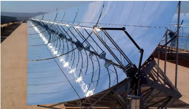
ABBILDUNG 264: Parabolrinnenkraftwerk
