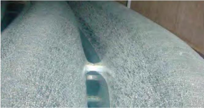
ABBILDUNG 276: Speicher eines Eisspeicherheizsystems am Ende der Heizperiode - BILD: ISOCAL HeizKühlsysteme
