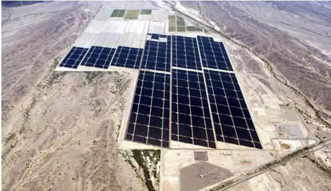
ABBILDUNG 256: 2013 größter PV-Park der Welt mit 290 MW Leistung auf 970 Hektar in Arizona, USA - BILD: Solarwatt, NRG Energy
