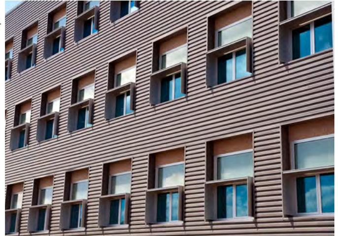
ABBILDUNG 247: Schema eines Luftkollektors, (rechts) Gebäude mit Luftkollektor, in der Fassade integriert, USA - BILD: SolarWall
