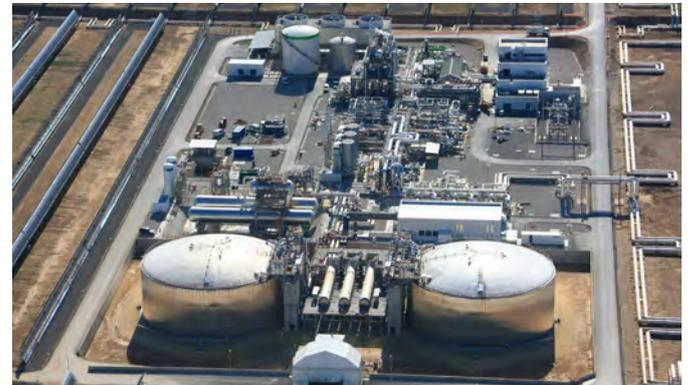
ABBILDUNG 265: Kraftwerksblock Valle, Spanien: 51 ha Kollektorfläche mit 50 MW Leistung erzeugen Strom für 80.000 Haushalte. - BILD: Torresol Energy
