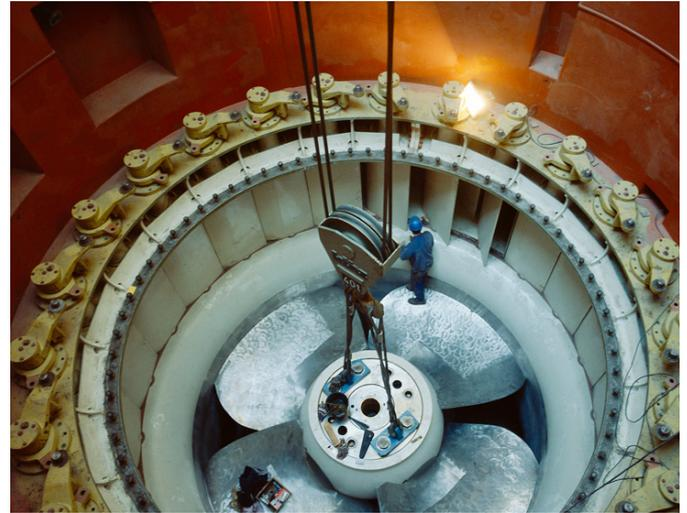
ABBILDUNG 214: Kaplan-Turbine - BILD: US Bureau of Reclamation
