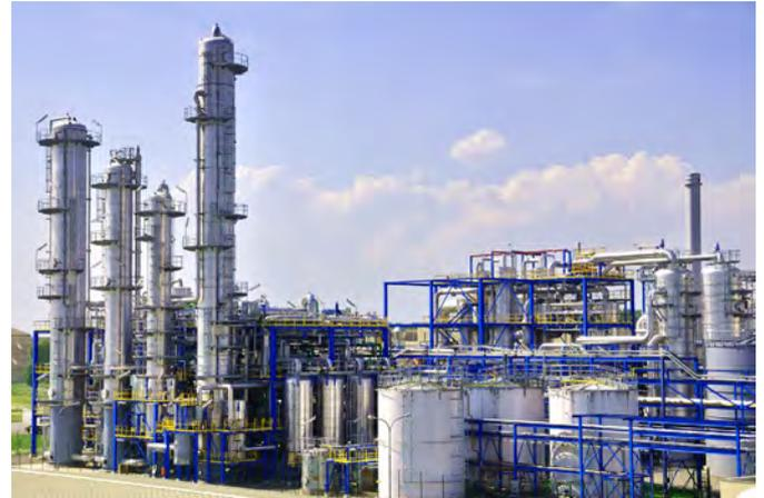
ABBILDUNG 192: Bioethanolanlage in Pischelsdorf, produziert jährlich rund 220.000 m<sup>3</sup> Bioethanol – BILD: Putschögl
