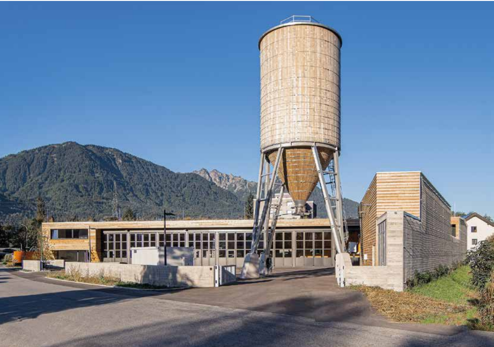
Straßenmeisterei Feldkirch Süd – Bludesch Neubau der Straßenmeisterei mit dem Verwaltungsteil als Niedrigstenergiehaus Standard Baufertigstellung 2023
