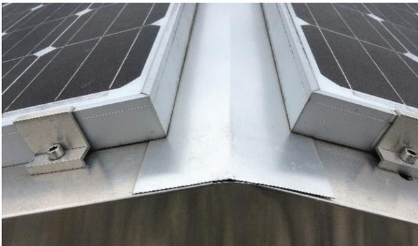
**Lösungsansatz:** Die Lücken müssen mit festen und dauerhaften Abdeckungen (z.B. aus Blech) geschlossen werden.
