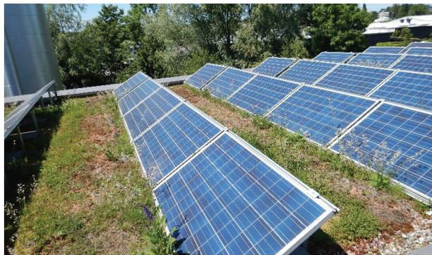
**Lösungsansatz:** 1-2 Pflegegänge direkt vor den Modulen in der starken Pflanzenwachstumszeit (Mai - Juni). Auslegen von dünnen Keramikplatten (ca. 30 cm breit) vor den Modulkanten, möglichst mit geschlossenen Fugen. Aufständering (etwa 15 bis 30 cm), um Schattenwurf bestmöglich zu vermeiden.
