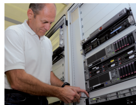
Markus Burger montiert ein Abdeckblech, das die Luftwege beeinflusst
