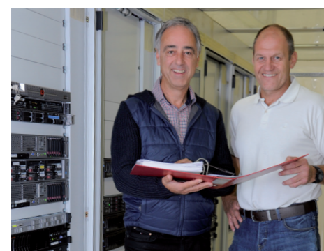
Kaltgang – Trennung zwischen Warm- und Kaltbereich durch Abschottung – Projektleiter Gerhard Raudnicky und Elektroinstallateur Markus Burger
