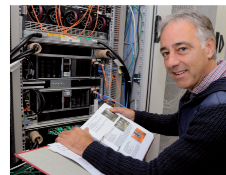
Gerhard Raudnicky vor einem Serverschrank – die Kühlluft strömt durch das Gerät und wird im Warmbereich wieder abgesaugt
